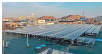
入間市にある太陽光発電パネルの設置風景
