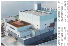
はつかいちエネルギーセンター
