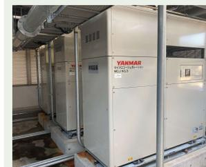
排熱投入型吸収冷温水機
