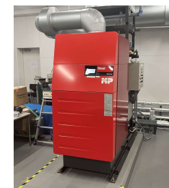
潜熱回収型温水器
