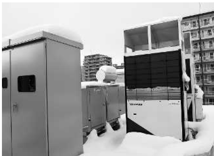
雪の中、稼働続けるGHP。後対応型20馬力と13
