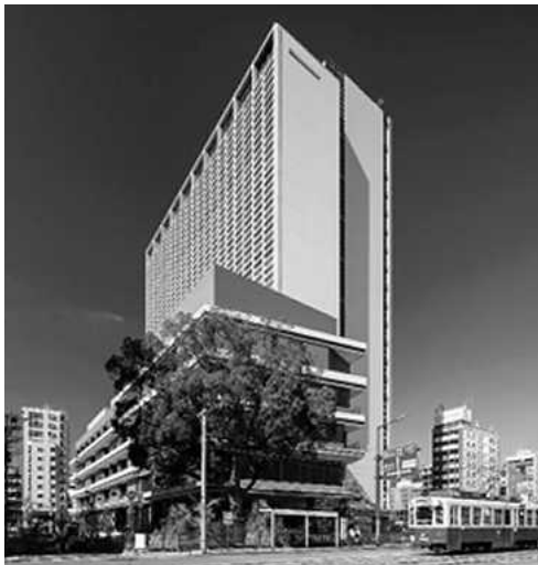
コージェネを設置した長崎市庁舎
