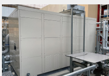
排熱投入型吸収冷温水機
