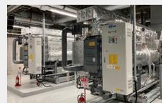
排熱投入型吸収冷温水機
