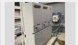
潜熱回収型ガス給湯器
