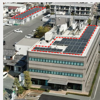
太陽光発電設備
